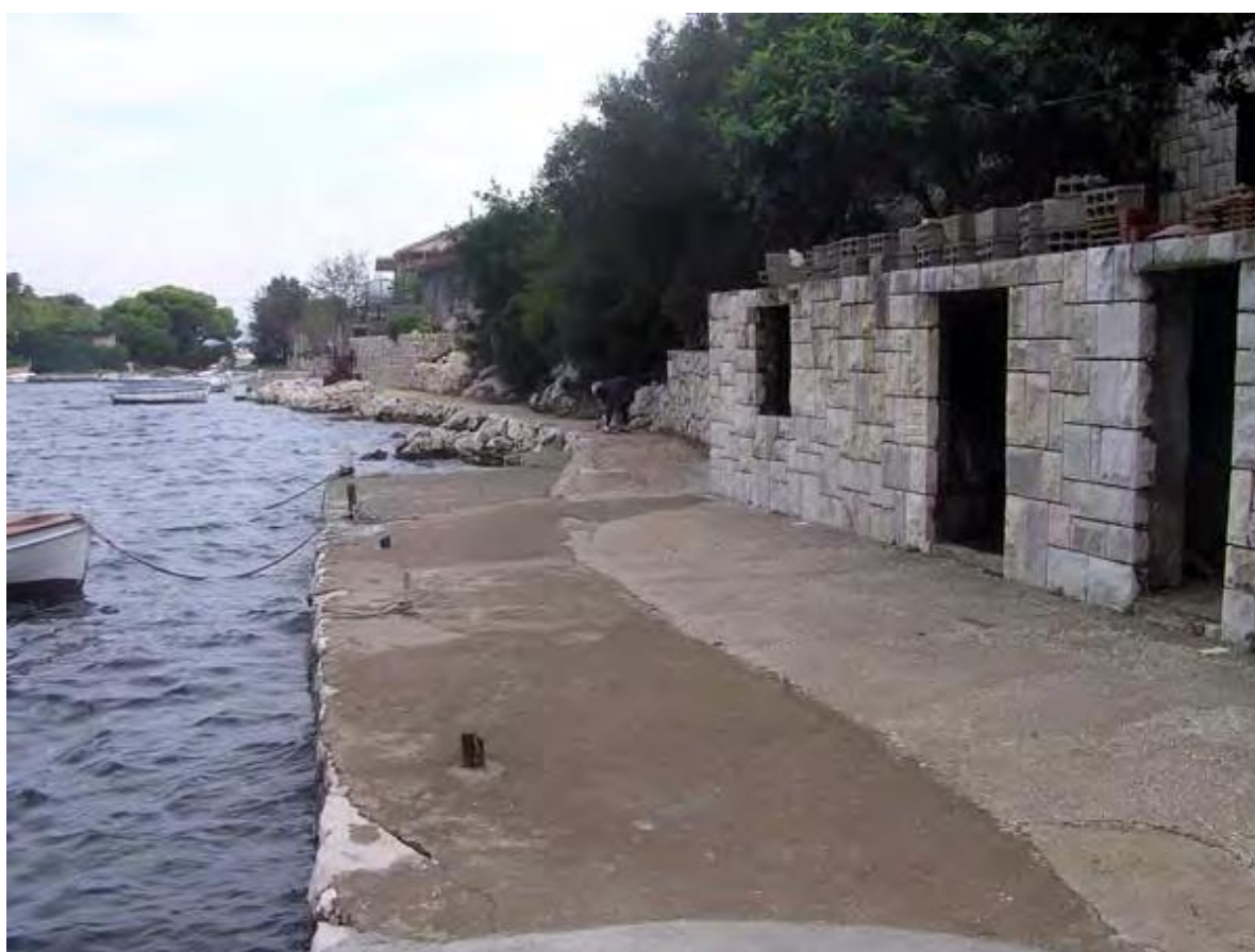
Slika 2.1 Izgled postojeće „rive“ (Izvor: Idejno rješenje)
